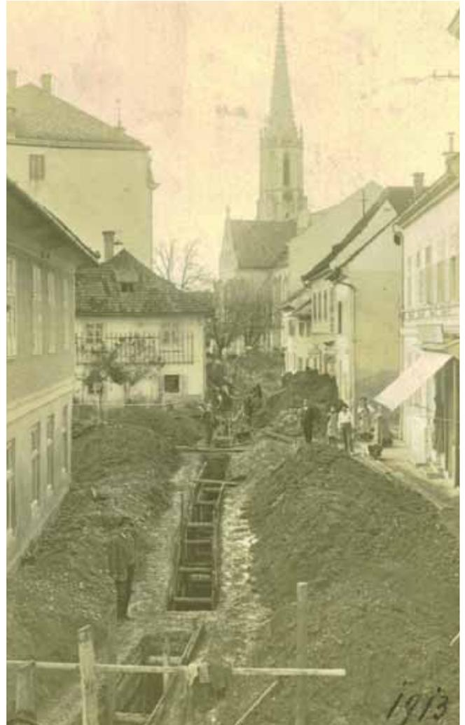
*Wasserleitungsbau 1913 in Bad Hall: Von Februar bis Juli 1913 wurde das gesamte Netz errichtet, die Pumpenanlage von der Eduardshöhe angelegt und ein betonierter Speicher angelegt.*
